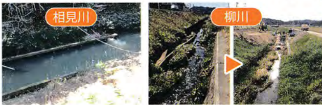
護岸工事が決定
