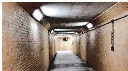
道路照明のLED化
