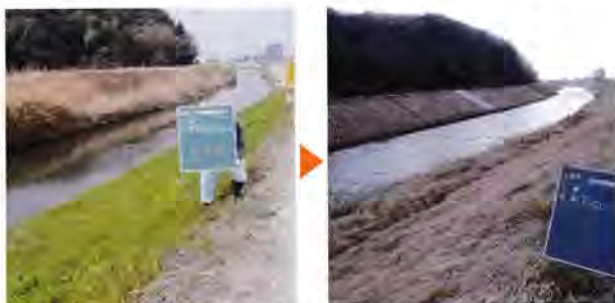
広田川（永野橋下流）の工事前（左）と工事後（右）
