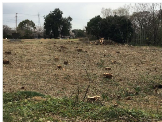
▲移転整備工事が始まりました
