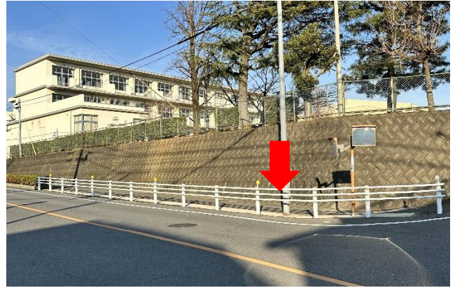
防護柵設置完了 幸田小学校西側
