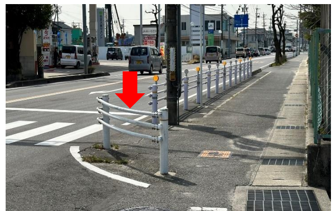
防護柵設置完了 矢作北小学校北東交差点
