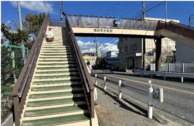
矢作南小学校横 横断歩道橋改修工事完了
