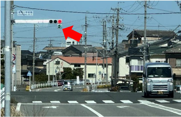
右折信号設置完了 福岡小学校南交差点
